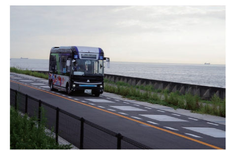
充電コイルが埋設されている道路をEVバスが走る様子。白く塗られた箇所の地中に、設備が埋められている。
