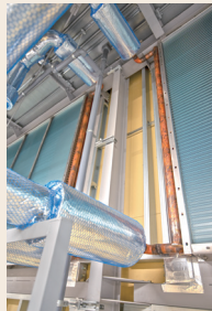
▲「直接外気冷却」壁吹き出しで排熱を回収する方式。条件外は屋上の空冷チラー＋冷水コイルに切替え、加湿・除湿で室温を整える。
