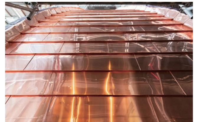
銅板屋根は横葺きとなっている。写真のような金属光沢が残る付まいの八角塔が見られるのは、庁舎へ復旧した直後のみになるだろう。
