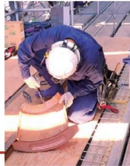
平瓦型銅板の最上部は絞り加工が施されており、職人が手作業で絞りをしている。
