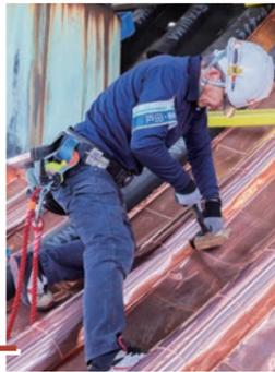
2枚の銅板の端を折り曲げ、引っ掛け合わせて継ぐ「はせ組」で繋ぎ合わせている。はせ部分を木槌で叩いて組み合わせる。
