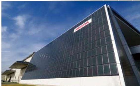
事務所の壁面には21kWの太陽電池モジュールが設置され、発電した電力は事務所の照明に利用されている。
