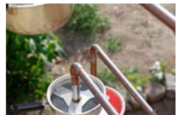
銅管の先にトライや洗面器などを接続
