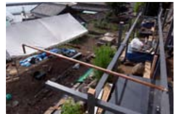
展示場所を整地し、銅管を設置
