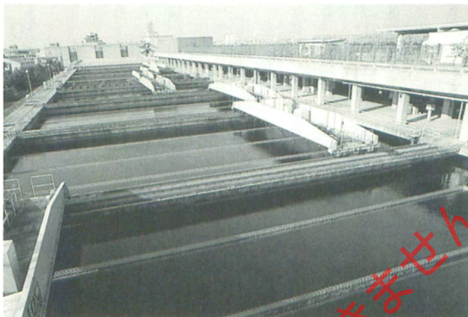
森ヶ崎下水処理場第二沈殿池
