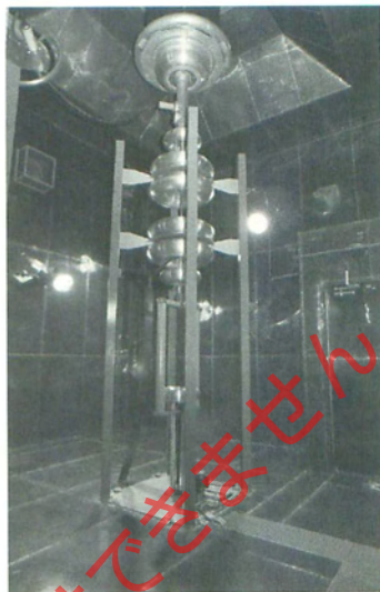
はがね山標準電波発信所整合器室。 銅板ですべてシールドされています
