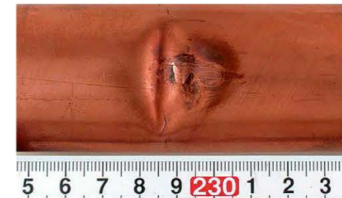
写真(1) 割れ部の外観
