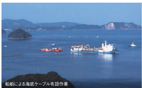
船舶による海底ケーブル布設作業
