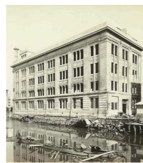
渋沢栄一が兜町に開業した日本初の民間銀行「第一国立銀行」の本店分館として、大正12(1923)年に竣工した。ちなみに名称に入っている「国立」とは、国が定めた銀行条例に従うという意味で、資本や運営は民間の合本組織が行った。
