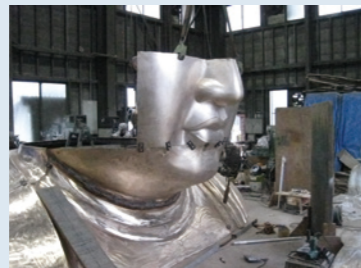
すべてのパーツができ上がると、工場で仮組みを行いパーツのひずみを矯正する
