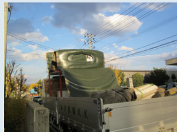
分割したパーツの総重量は約65t! トラック19台で10日間かけて搬送した
