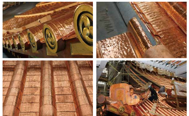
急ピッチで進められる銅瓦葺き屋根工事
