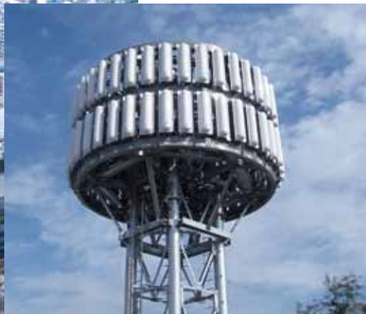
位置や角度はアンテナにとって非常に重要なため、工場内でアンテナを組み立て、角度や位置を高精度に調整した。
