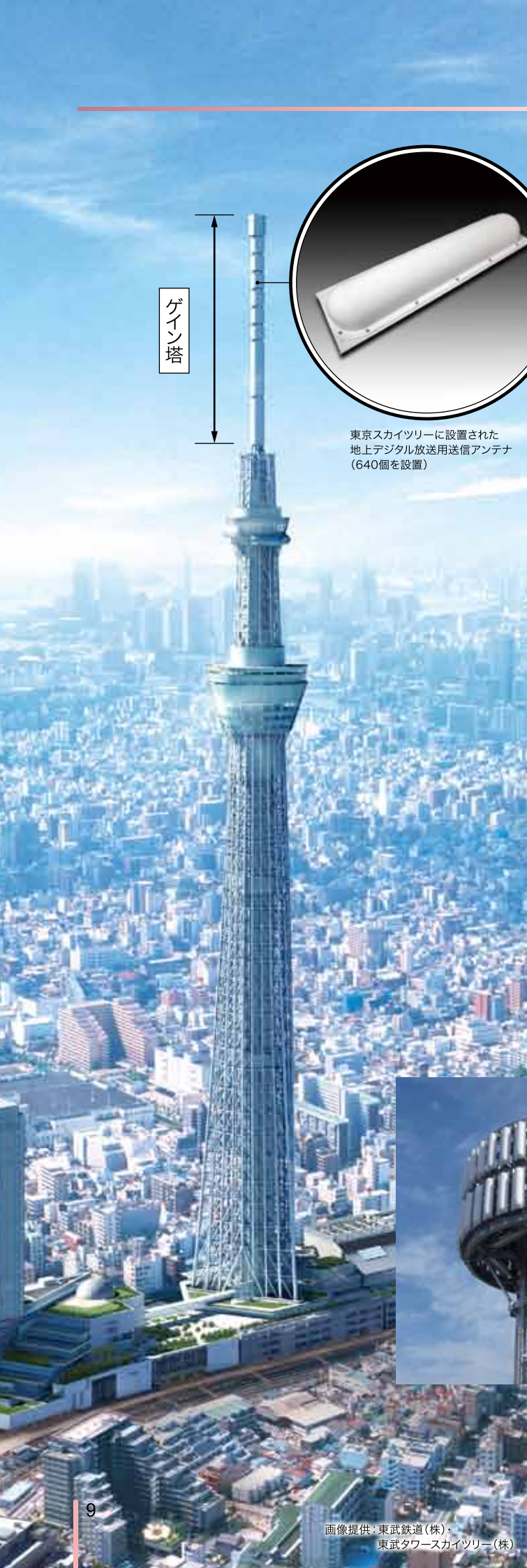
位置や角度はアンテナにとって非常に重要なため、工場内でアンテナを組み立て、角度や位置を高精度に調整した。
