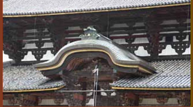
▲東大寺大仏殿には、部分的に銅屋根が採用されている
