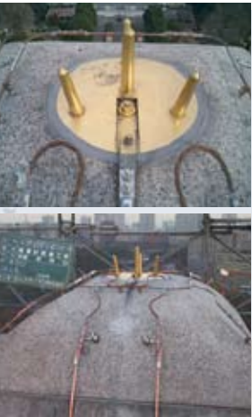
既設避雷針周囲に銅線の導体を強化
