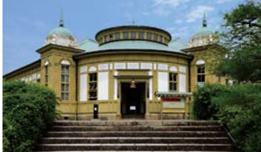
宇治山田郵便局 (建設：明治42年／移築：昭和44年)
