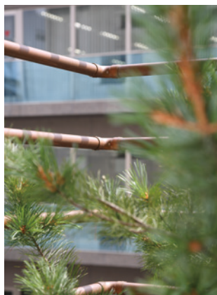
▲コーナーの銅管接合部
