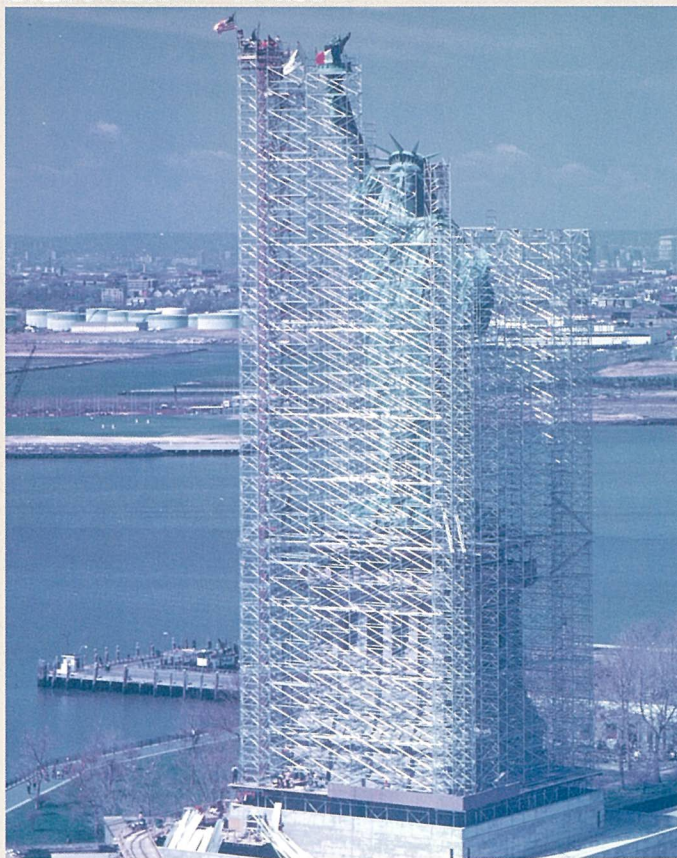
組み上げられた高さ76メートルの足場
