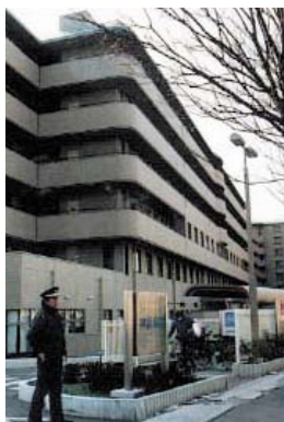
震災では敷地地盤の沈下、内外壁損傷、天井破損などの被害があった
