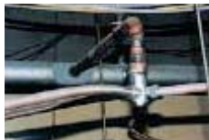
消防スプリンクラー用銅配管
