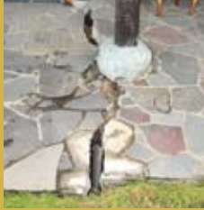
地割れが、玄関から家の中を突き抜けたY氏宅、それでも銅管に損傷はみられなかった
