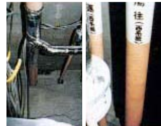
50A以下の銅管を消防スプリンクラー（ヘッド数2,700個）に使用
