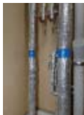
ホテルに使用されている給湯用銅配管
