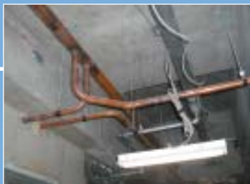
6階天井銅配管
