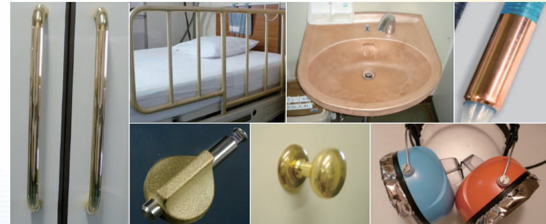
● 病棟に設置した銅および黄銅製の部材
